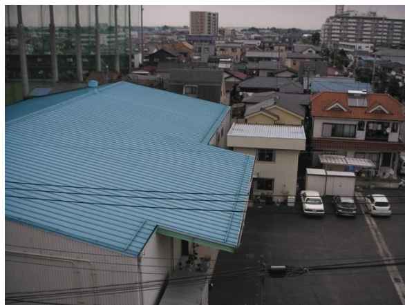
屋根塗装箇所
